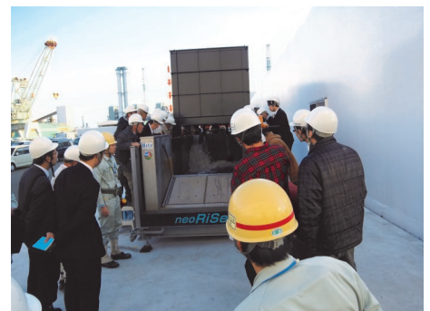
フラップゲート式可動防潮堤
